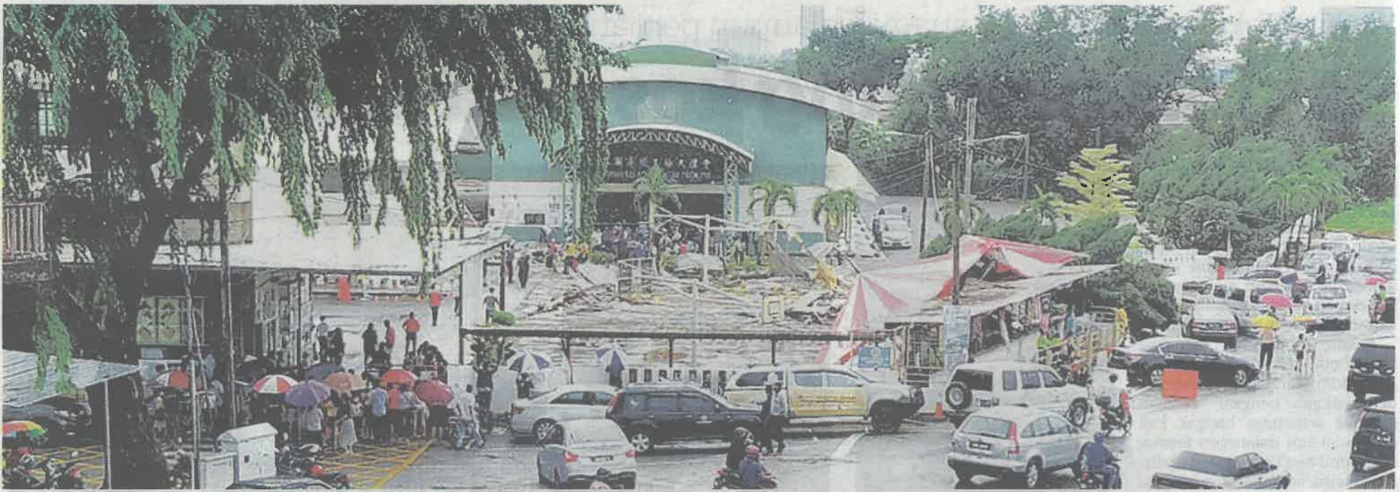
ORANG ramai berkumpul di hadapan SJKC Malim untuk melihat keadaan sekolah itu yang rosak teruk selepas dibadai puting beliung dalam kejadian di Melaka semalam. – RASUL AZLI SAMAD
