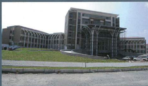
BANGUNAN CANSELORI DAN PENTADBIRAN
