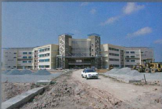
BANGUNAN KULLIYAH KEJURUTERAAN & KULLIYAH TEKNOLOGI SAINS MAKLUMAT
