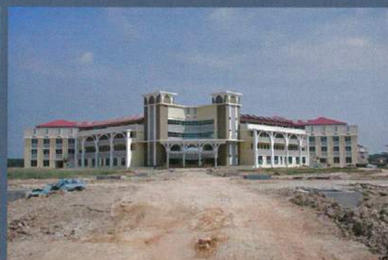
BANGUNAN KULLIYAH SYARIAH & KULLIYAH BAHASA ARAB
