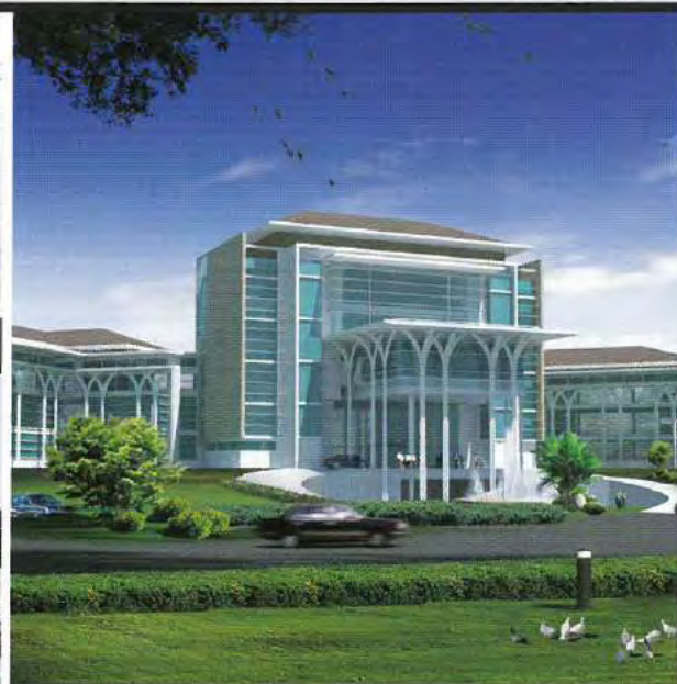
Bangunan Canselori Pandangan Hadapan
